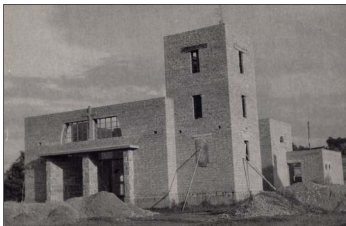
Az épülő templom 1958-ban
