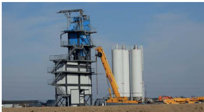
Körmenden gigantikus méretű aszfaltkeverő épül
