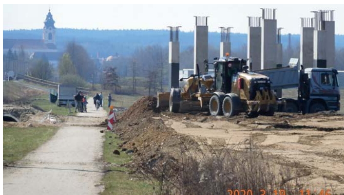
Felüljáró épül Szentgotthárdon a Füzesi úton
