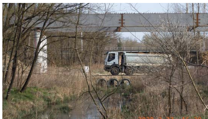
300 méter hosszú felüljáró Körmend előtt a Csencsi-patak felett
