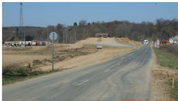
Csörötnek és Rönök közötti ájtáró és kerülőút építése
